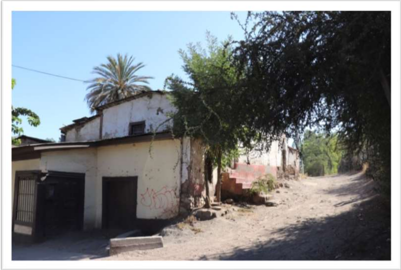
Calle Santiago Bueras, acceso Cerro San José, Curimón
